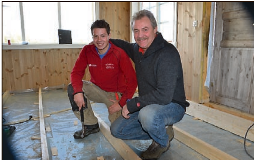
TRIVES: Frode Rundhaug er ferdig utdannet tømrer og har fått fast jobb i firmaet. Her er Frode sammen med byggeleder Arild Tørhaug i nok ei hytte som er under oppføring i Synnfjellet.
